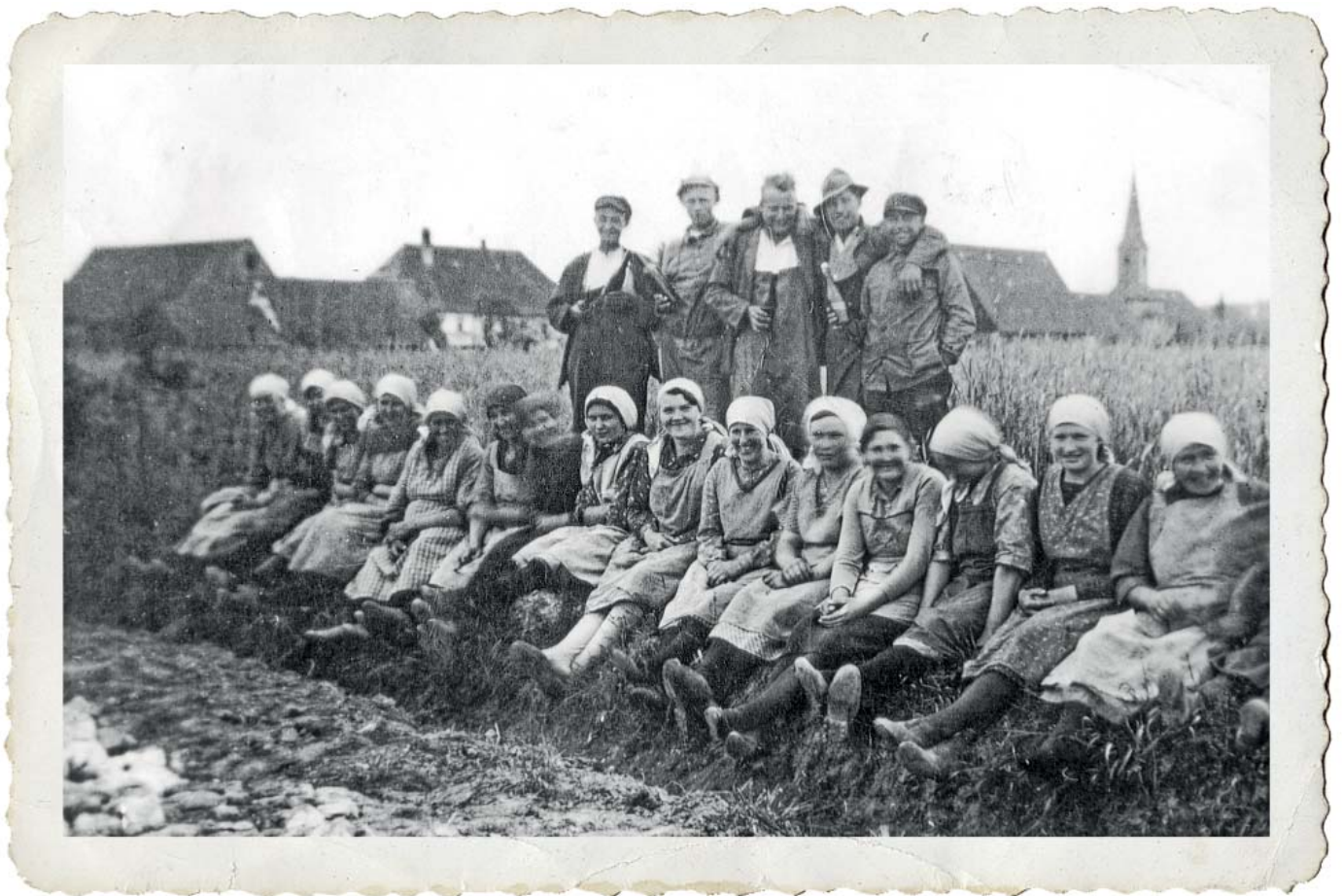
Wegbauarbeiten mit Spaten und Schaufel in Oberreichenbach im Jahr 1935
